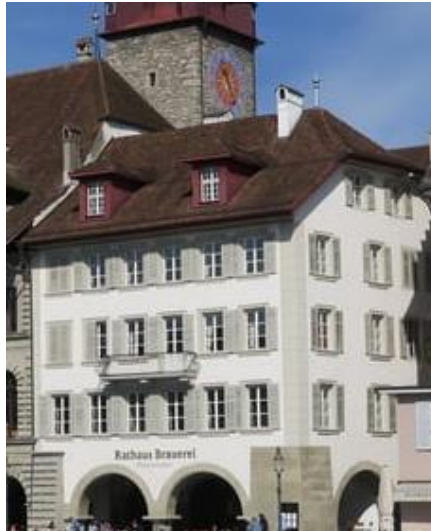
Der dritte Wohnsitz der Familie von Max Schumacher, die die gesamte dritte Etage des Vorder- und Hinterhauses gegen die Reuss und die Furrengasse bewohnte. Zu den interessanten Räumlichkeiten zählt insbesondere der grosse Saal mit der gewölbten Decke und der prächtigen Stuckatur.
